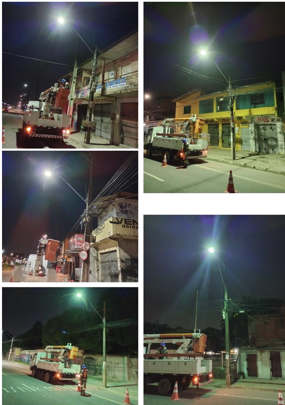
Figura 4 - Execução do serviço de manutenção corretiva. Fonte: LUZ DE BELÉM, 2022
